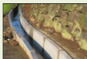
素堀り水路からの更新
