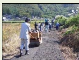
未舗装農道の舗装
