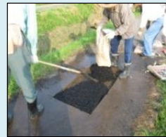
農道の部分補修
