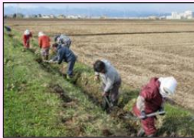
水路の泥上げ
