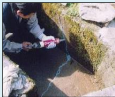
ひび割れの補修
