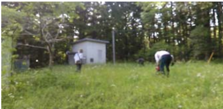
水源貯水池周辺地の草刈り作業
