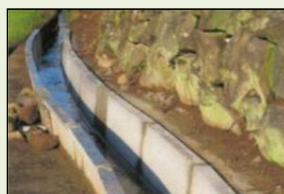
素堀り水路からの更新
