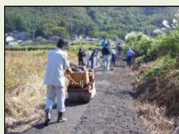
未舗装農道の舗装
