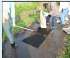
農道の部分補修
