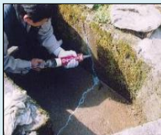
ひび割れの補修
