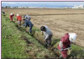
水路の泥上げ
