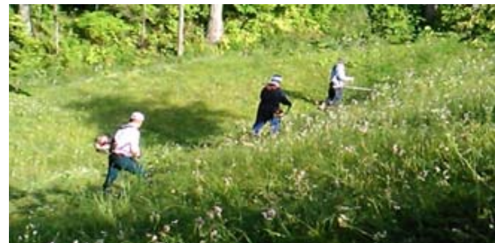
水源貯水池周辺地の大きい法面の草刈り作業
