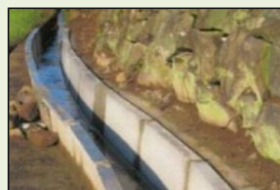
素堀り水路からの更新
