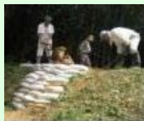
漏水箇所の補修
