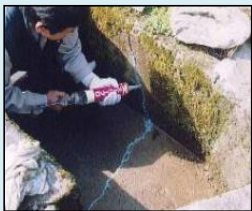
ひび割れの補修
