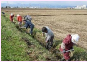
水路の泥上げ
