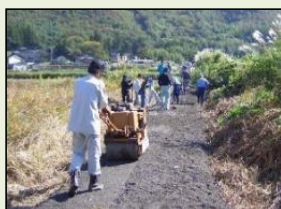
末舗装農道の舗装
