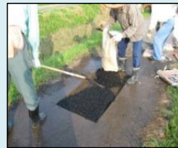
農道の部分補修
