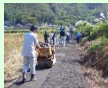
未舗装農道の舗装
