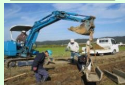
コンクリート水路の更新
